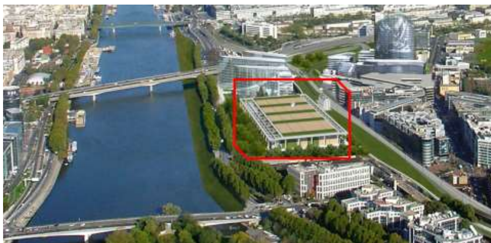
Рис. 25. Завод по термической переработке ТКО Issy-Les-Moulineaux, Париж
