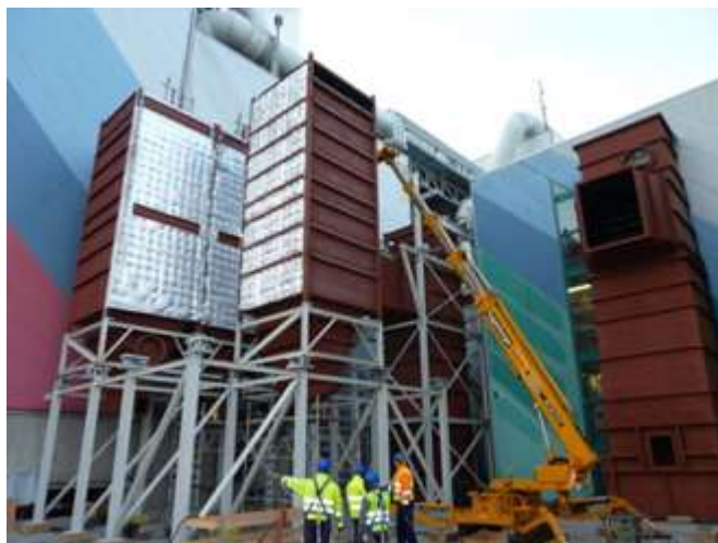
Рис. 18. Монтаж блоков рукавного фильтра
