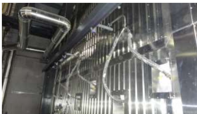
Рис. 15. Впрыск \text{NH}_4\text{OH} в активной зоне котла
