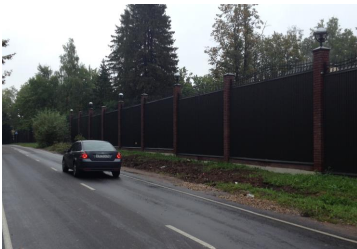
Фото 2. Участок автомобильной дороги регионального значения «М-3 «Украина» – Сырьево»
