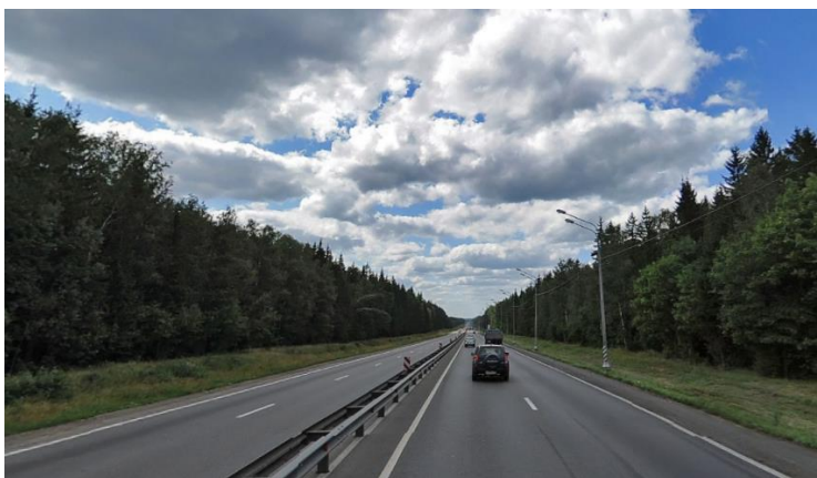
Фото 1. Участок автомобильной дороги федерального значения М-3 «Украина»
