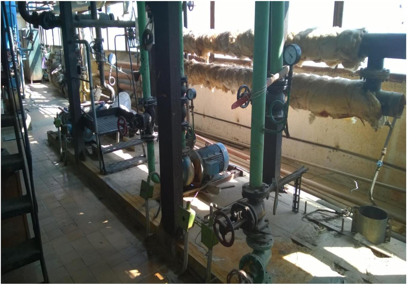
Рисунок 2.5. Насосное оборудование котельной.
