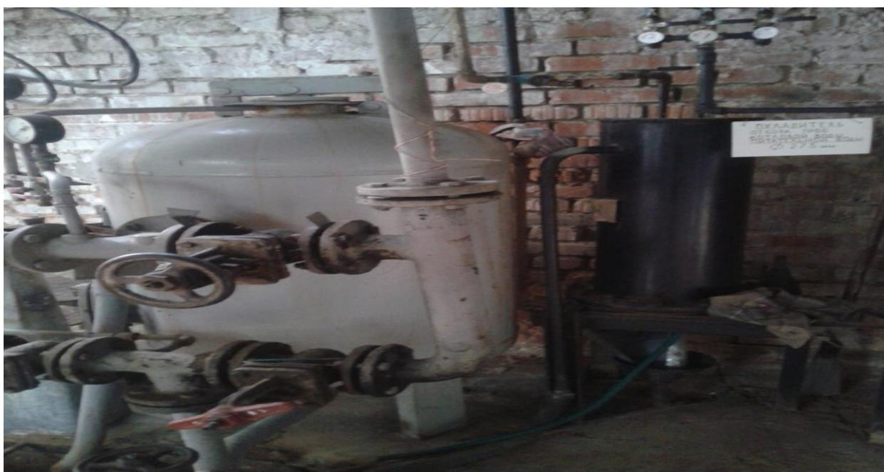
Рисунок 2.8. Охладитель отбора проб котловой воды.
