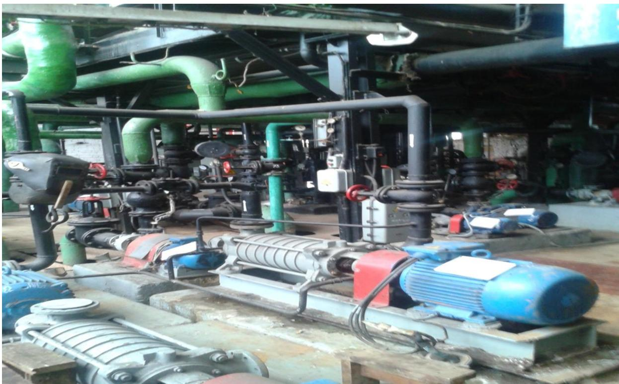
Рисунок 2.7. Насосное оборудование котельной.
