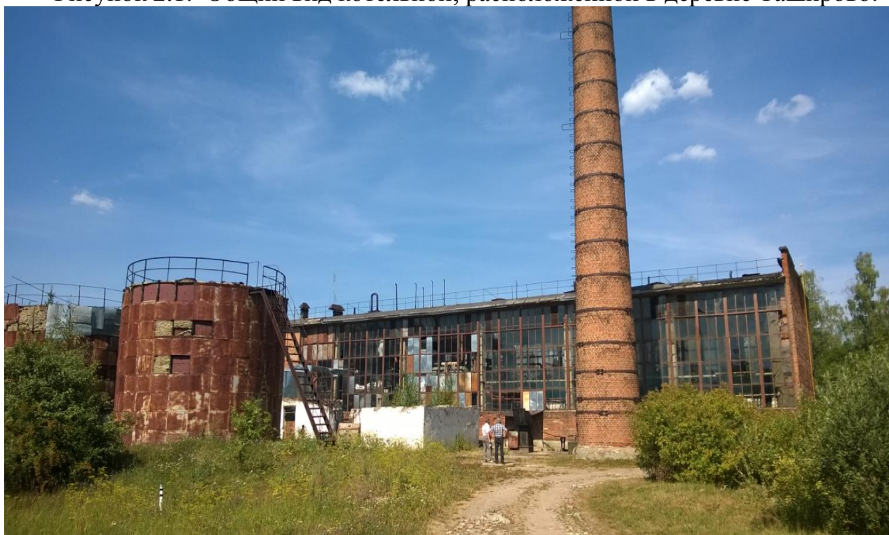
Рисунок 2.2. Общий вид котельной, расположенной в жилом городке № 12.
