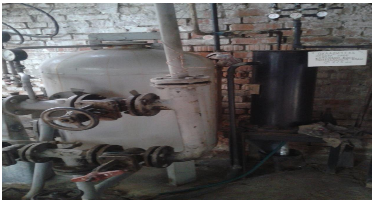
Рисунок 2.8. Охладитель отбора проб котловой воды.
