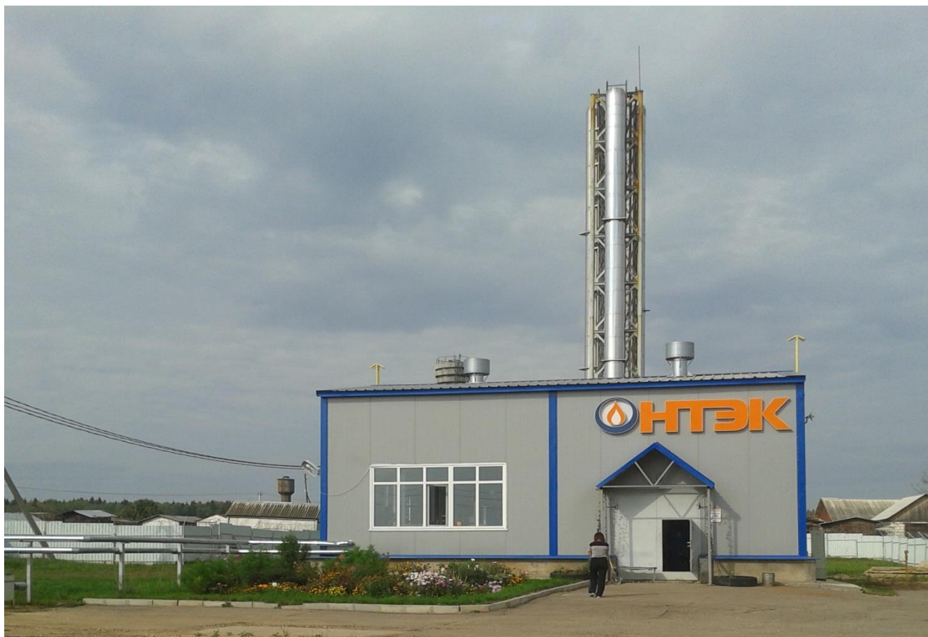
Рисунок 2.3. Общий вид котельной, расположенной в деревне Головково.
