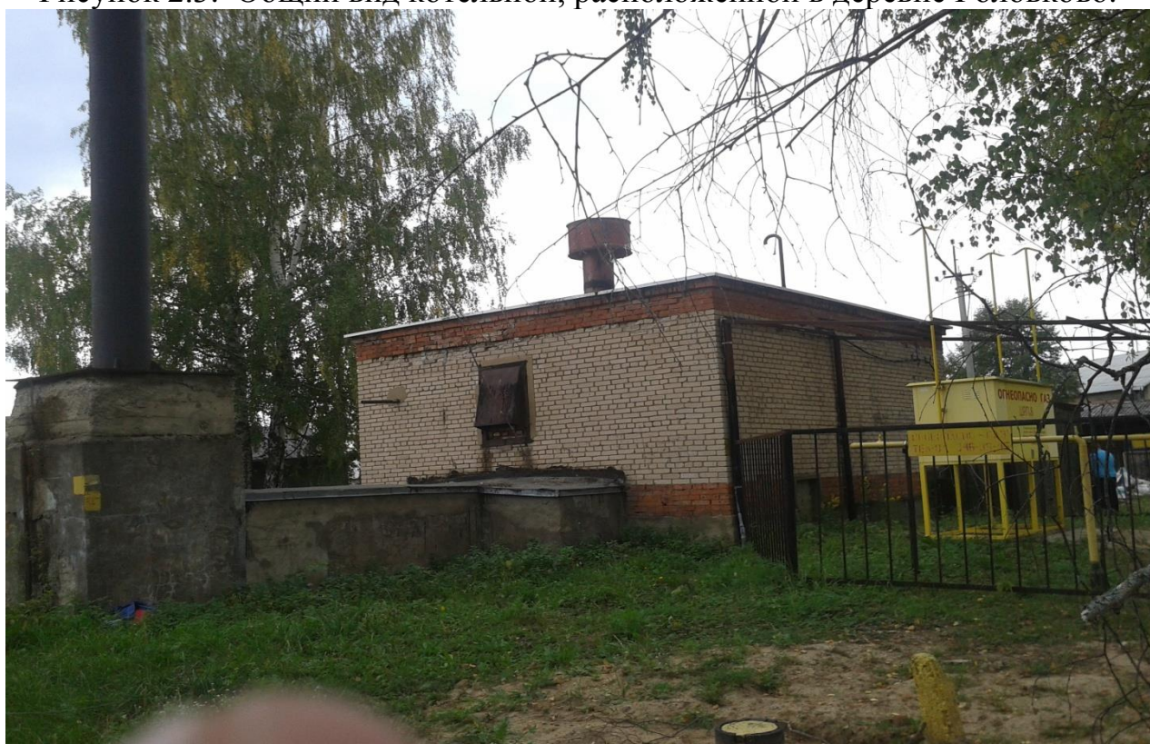
Рисунок 2.4. Общий вид котельной, расположенной в деревне Мякишево.
