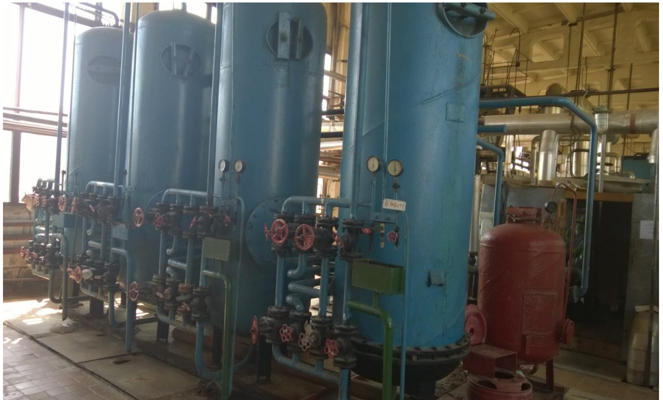
Рисунок 2.6. Установка водоподготовки.
