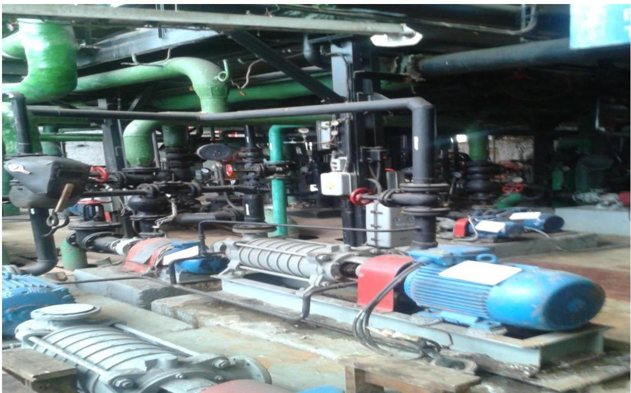
Рисунок 2.7. Насосное оборудование котельной.
