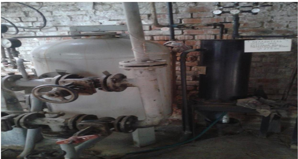
Рисунок 2.8. Охладитель отбора проб котловой воды.
