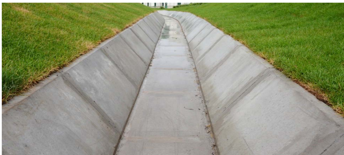
Рис. 1. Водоотводные канавы с бетонным укреплением.
