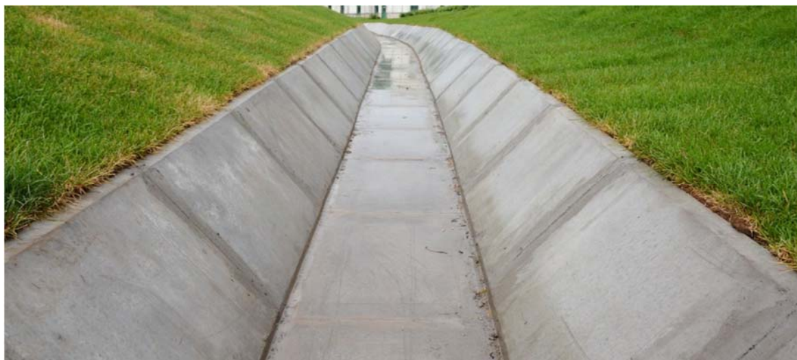
Рис. 2 – Водоотводные канавы с бетонным укреплением.
