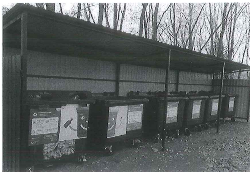
Рис. 4.13. Вариант обустройства контейнерной площадки
