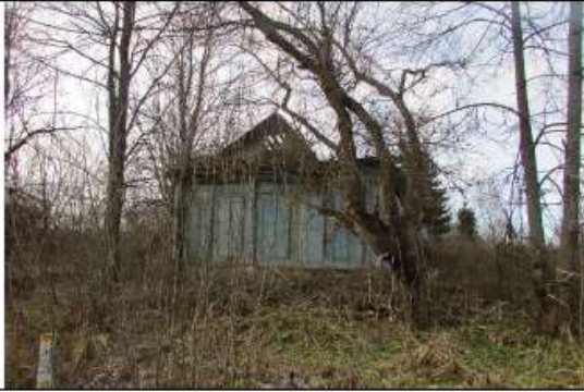
Рисунок 6.12 Внешний вид нежилого здания
