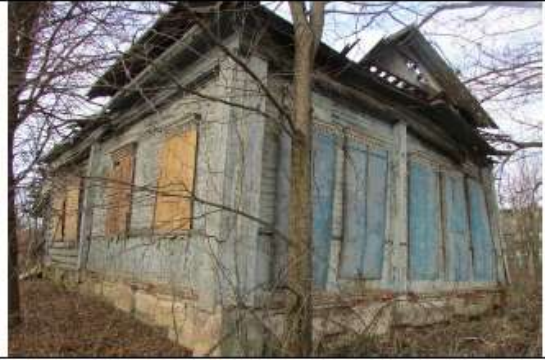
Рисунок 6.13 Внешний вид нежилого здания
