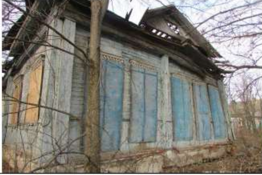
Рисунок 6.14 Внешний вид нежилого здания
