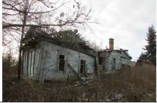
Рисунок 6.15 Внешний вид нежилого здания
