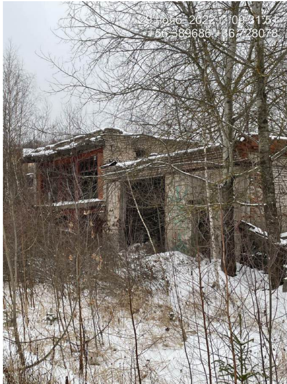
Здание растворного узла
