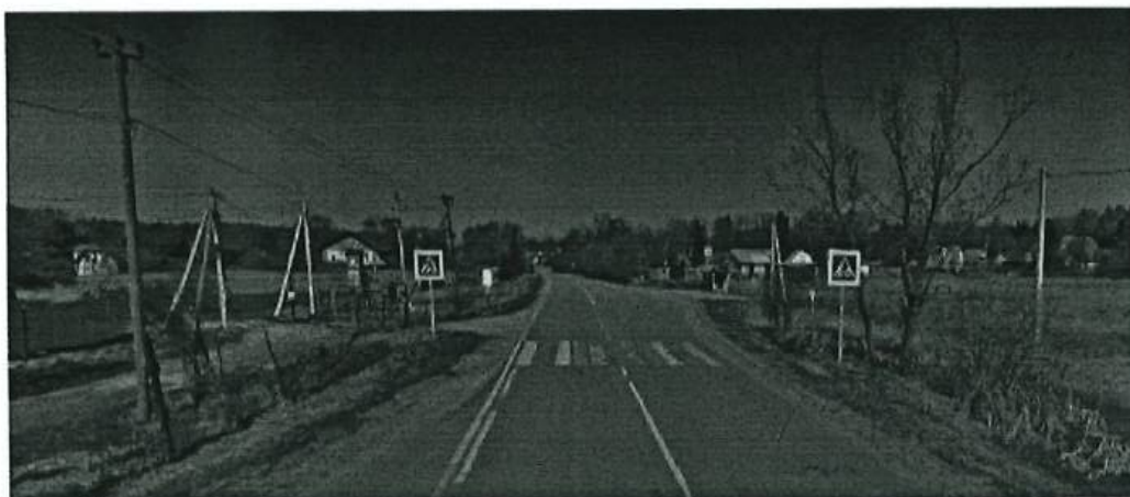
Рис. 1.2.2 Общий вид а/д «М-3 «Украина» - Афанасовка – Савеловка – Могутово» на рассматриваемом участке
