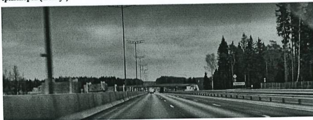
Рис. 1.2.1 Общий вид а/д М-3 «Украина» на рассматриваемом участке
